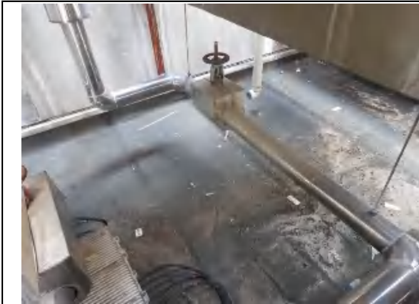
写真 No.91 塔屋屋根 全景 露出アスファルトシート防水
