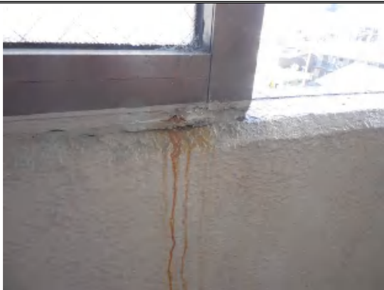
写真 No.45 5 階共用廊下 手摺内壁 塗膜への錆汁付着
