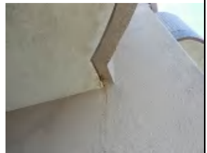
写真 No.45 5 階共用廊下 手摺内壁 塗膜への錆汁付着
