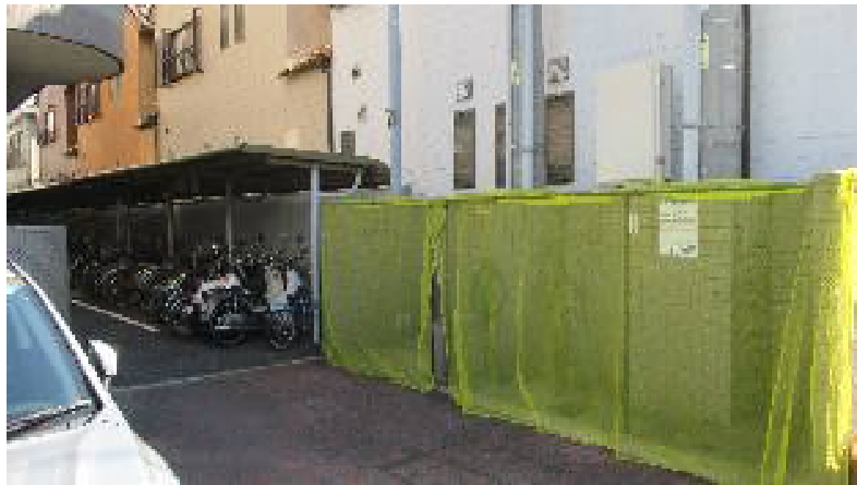
写真 No.163 南西ゴミ置き場 維持管理・美観対策 *アルミ扉設置
