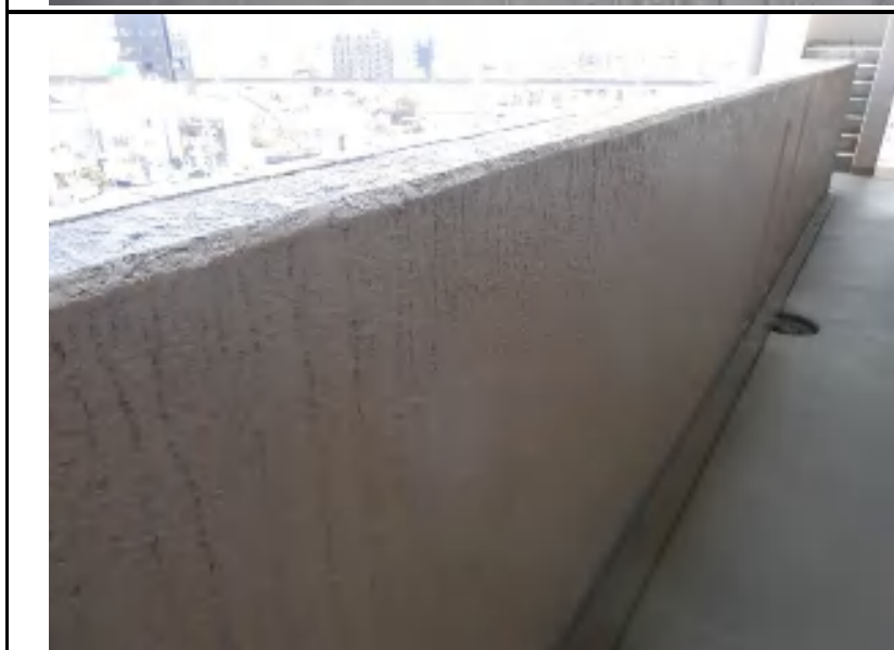
写真 No.42 8 階共用廊下 手摺内壁 塗膜の雨筋汚染
