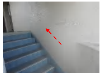
写真 No.42 8 階共用廊下 手摺内壁 塗膜の雨筋汚染
