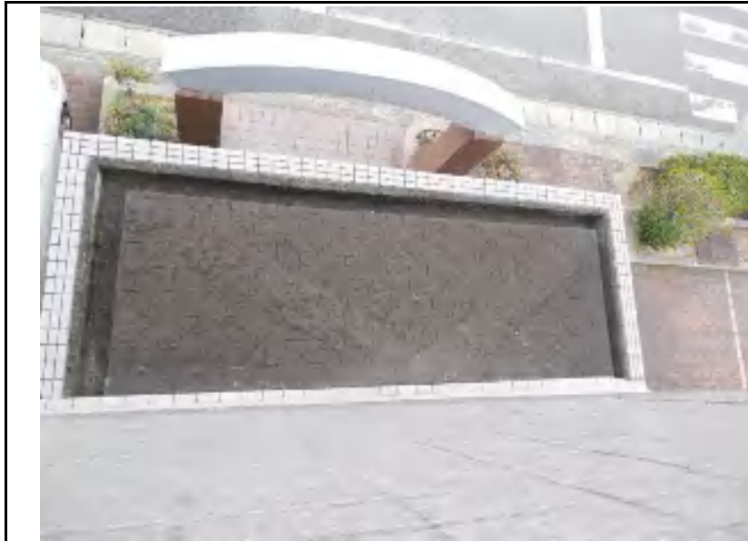
写真 No.115 エントランス庇 全景 アスファルトシングルルーフ
