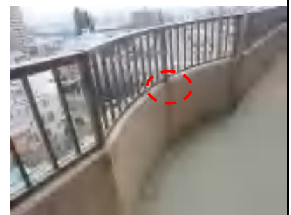
写真 No. 6 9階共用廊下 手摺支柱根本 爆裂
