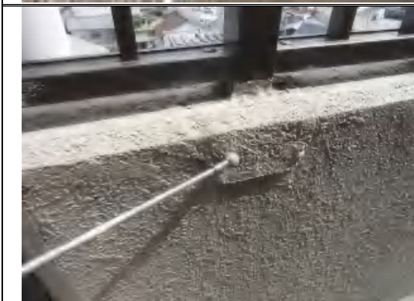
写真 No. 6 9階共用廊下 手摺支柱根本 爆裂
