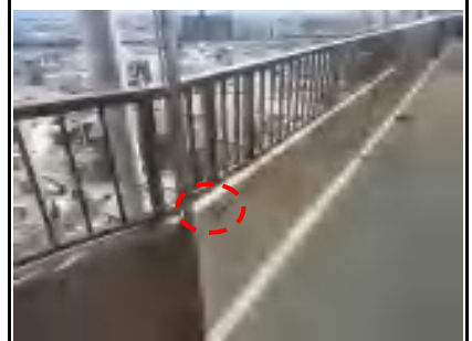
写真 No. 6 9階共用廊下 手摺支柱根本 爆裂
